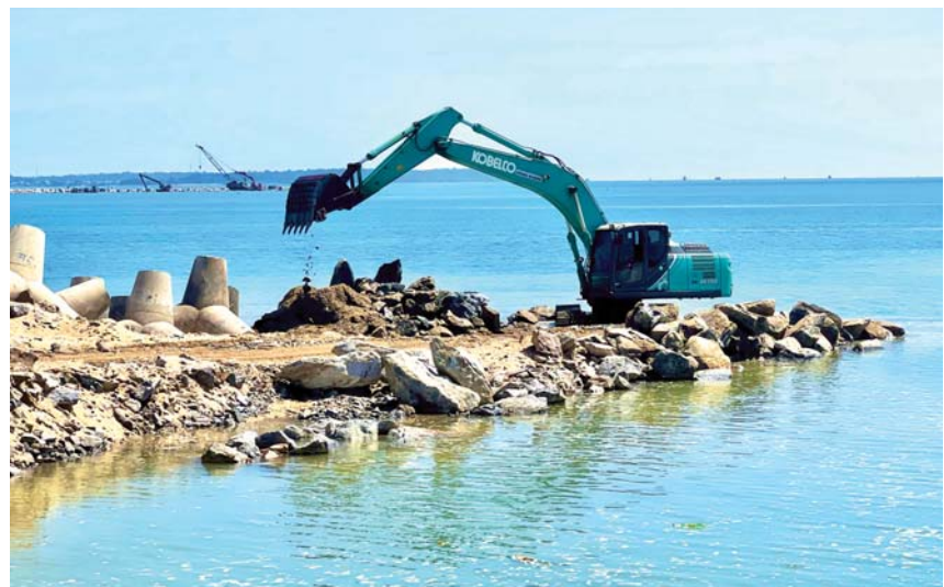
Nhà thầu đang đẩy nhanh tiến độ công trình nạo vét thông luồng Cửa Đại (TP. Quảng Ngãi). ẢNH: T.N
