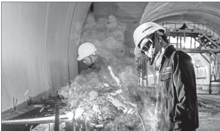
Công nhân thi công hầm số 3 trên cao tốc Quảng Ngãi - Hoài Nhơn dịp tết Ất Ty 2025.
