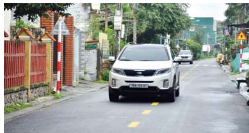
Hẻm 58 Mạc Đĩnh Chi, phường Lê Hồng Phong (TP.Quảng Ngãi) sau khi được đầu tư, nâng cấp.
