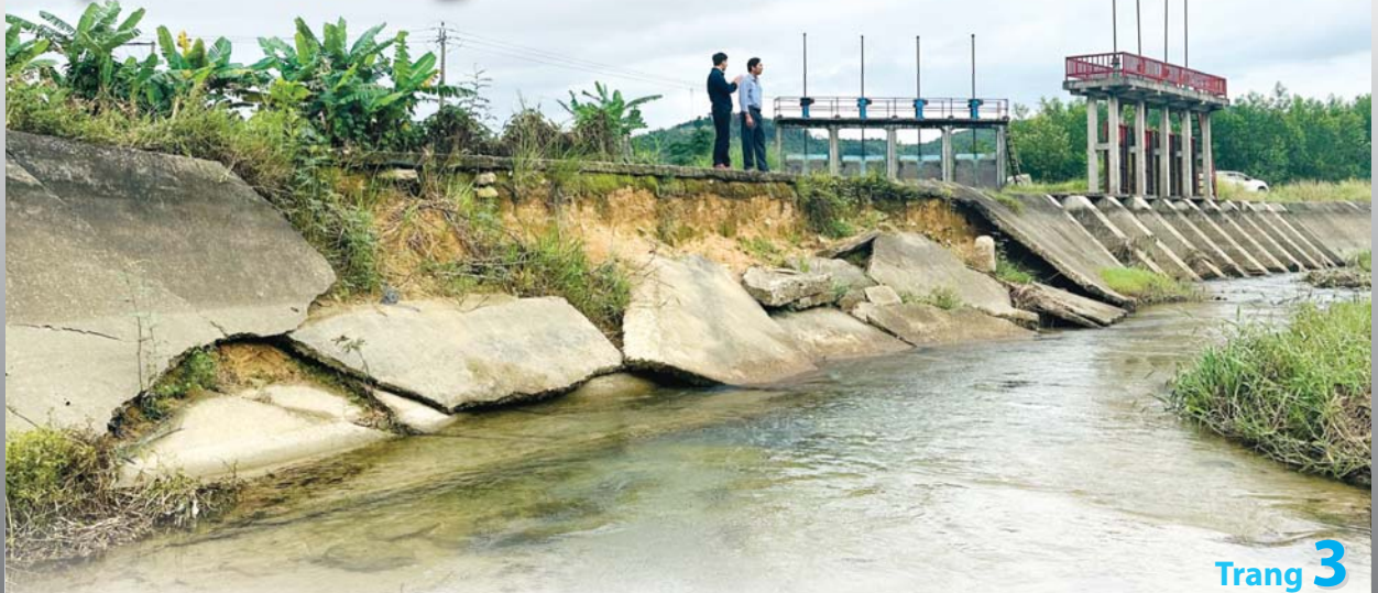
Kênh chính Núi Ngang, đoạn qua xã Phổ Phong (TX.Đức Phổ), bị sạt lở, hư hỏng nghiêm trọng.
