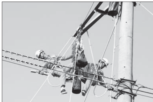
Công nhân ngành Điện kiểm tra, nâng cấp lưới điện 110kV trên địa bàn tỉnh.
