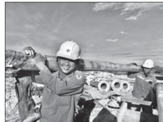
Niềm vui của công nhân Công ty Điện lực Quảng Ngãi trên công trường xây dựng đường dây 500kV mạch 3 tại Hà Tĩnh. ANH: DL
