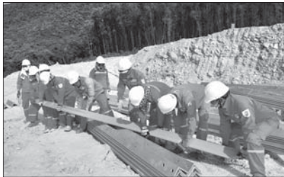
Đội quân tình nguyện của Công ty Điện lực Quảng Ngãi thi công đường dây 500kV mạch 3 Quảng Trạch - Phố Núi. ANH: DL
