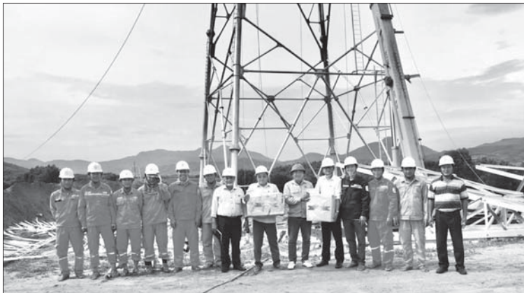
Lãnh đạo Công ty Điện lực Quảng Ngãi thăm, động viên Đội quân tình nguyện công ty tại công trường, ở huyện Kỳ Anh (Hà Tĩnh). ANH: DL
